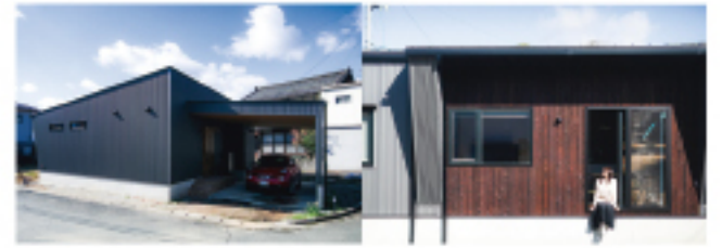
エ、カーポートを一体としたスタイリッシュな外観。雨の日も濡れることなく車から部内へ。シルバークラウンのガルバリウム鋼板は光の当たり方によって表情を変える。木、リビングのある南側の壁と軒天井には屋久島の地杉を採用しアクセントに。ヴィンテージ感のある塗装もカッコいい。
