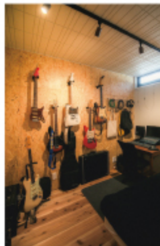
音楽が趣味の夫の居室は、新築材のセルローズファイバーを施工して防音仕様に。壁一面をOSBボードとし、ディスプレイやDIYの楽しみも促進する
